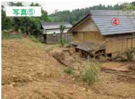
【土砂堆砂厚1m程度】
