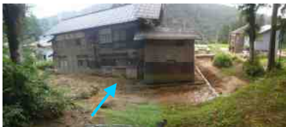
【土砂の堆積及び浸水】
