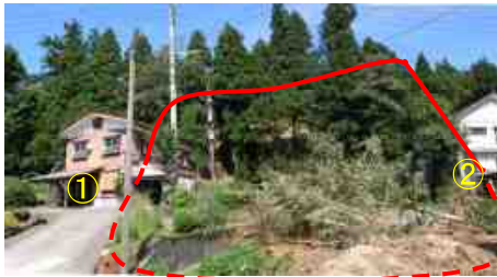
【崩壊により流出した土砂】
