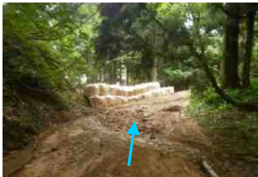
【応急対策工(大型土のうによる導流堤)】
