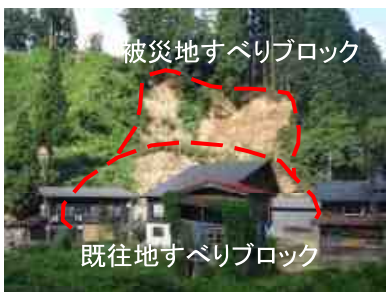
【羽根川対岸から地すべりを望む】
