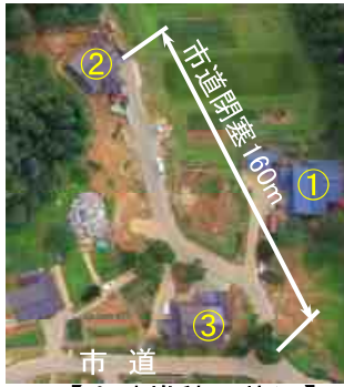
【土砂堆積の状況】
