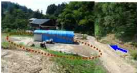
【土砂の氾濫痕跡】
