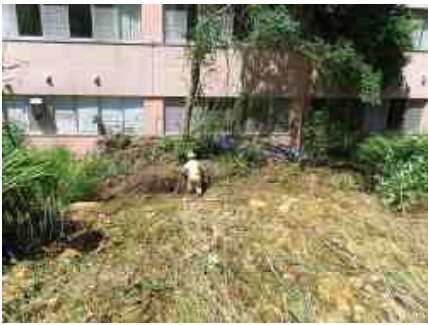
【保全対象①に到達した土砂】
