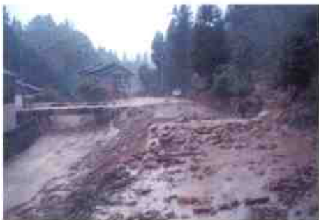
【市道の埋塞状況】
