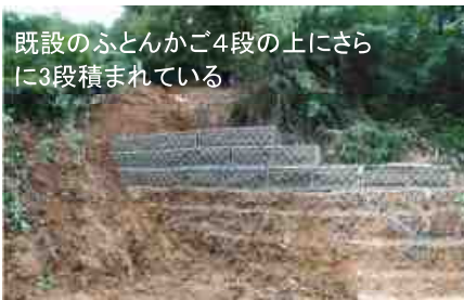
【大型ふとん管による応急対策】
