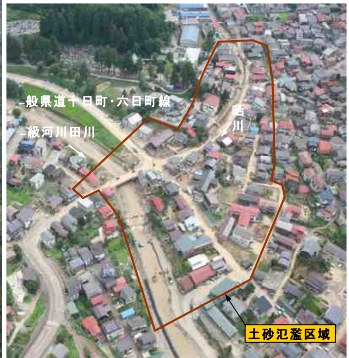
【晒川下流域の土砂氾濫区域】
