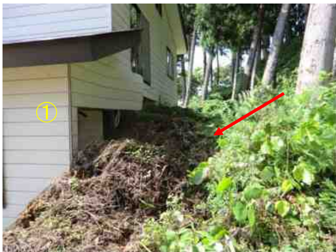
【①家屋の1階を埋め、室内に流入している土砂】
